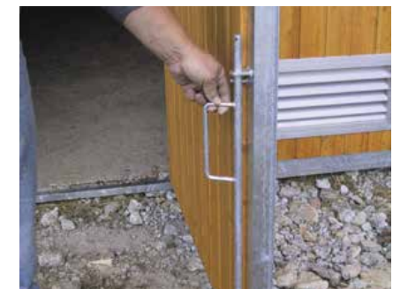
Innenverriegelung mit Treibriegel
