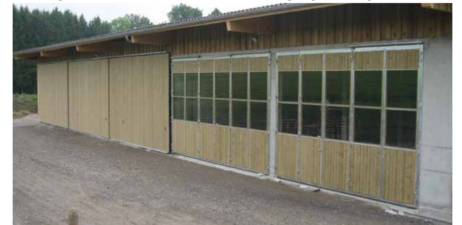
Holzstirne geschützt mit Stahlwinkel
