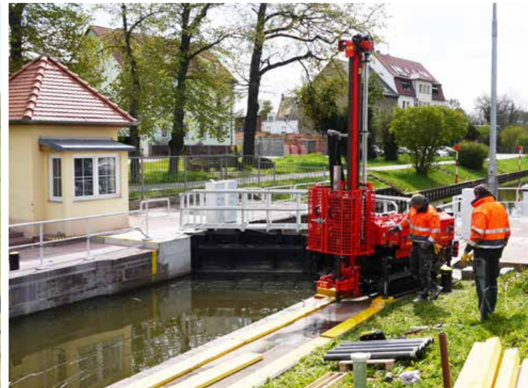
Kernbohrung an einer Kanalschleuse
