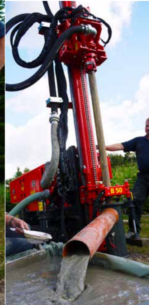
Entnahme von Materialproben aus dem Spülbohrwasser
