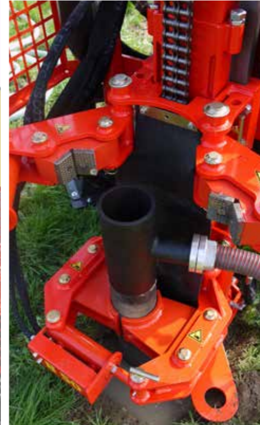
Wasserablauf beim Kernbohren
