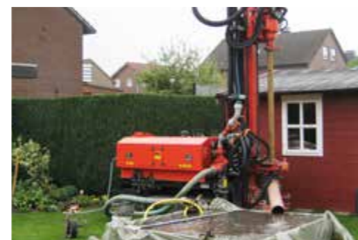
Brunnenbohrung im fertig angelegten Garten
