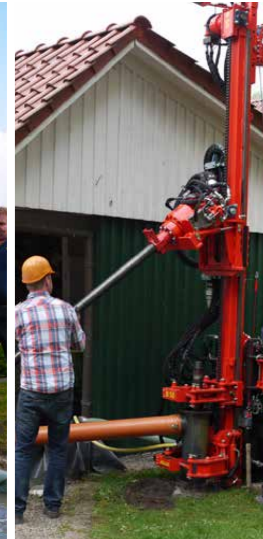
Gestängewechsel beim Spülbohrverfahren
