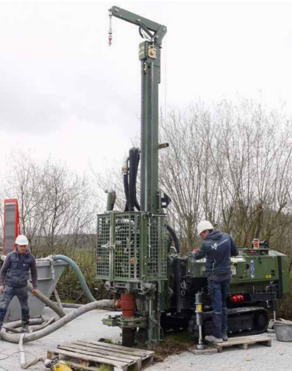
Spülbohren mit einem Wasserkreislauf über einen Container
