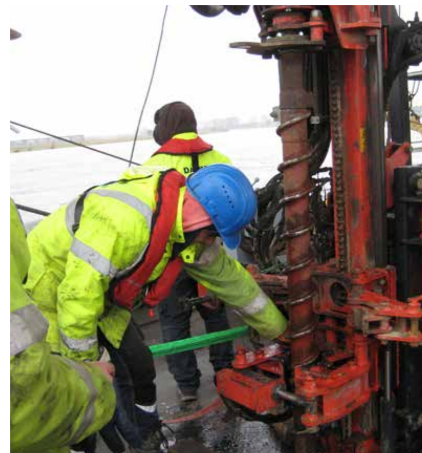
Sondierungsarbeiten mit der Hohlbohrschnecke auf einem Ponton im Rhein
