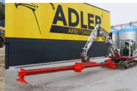
Aufstellen der Bohrlafette ABL mit dem Bagger
