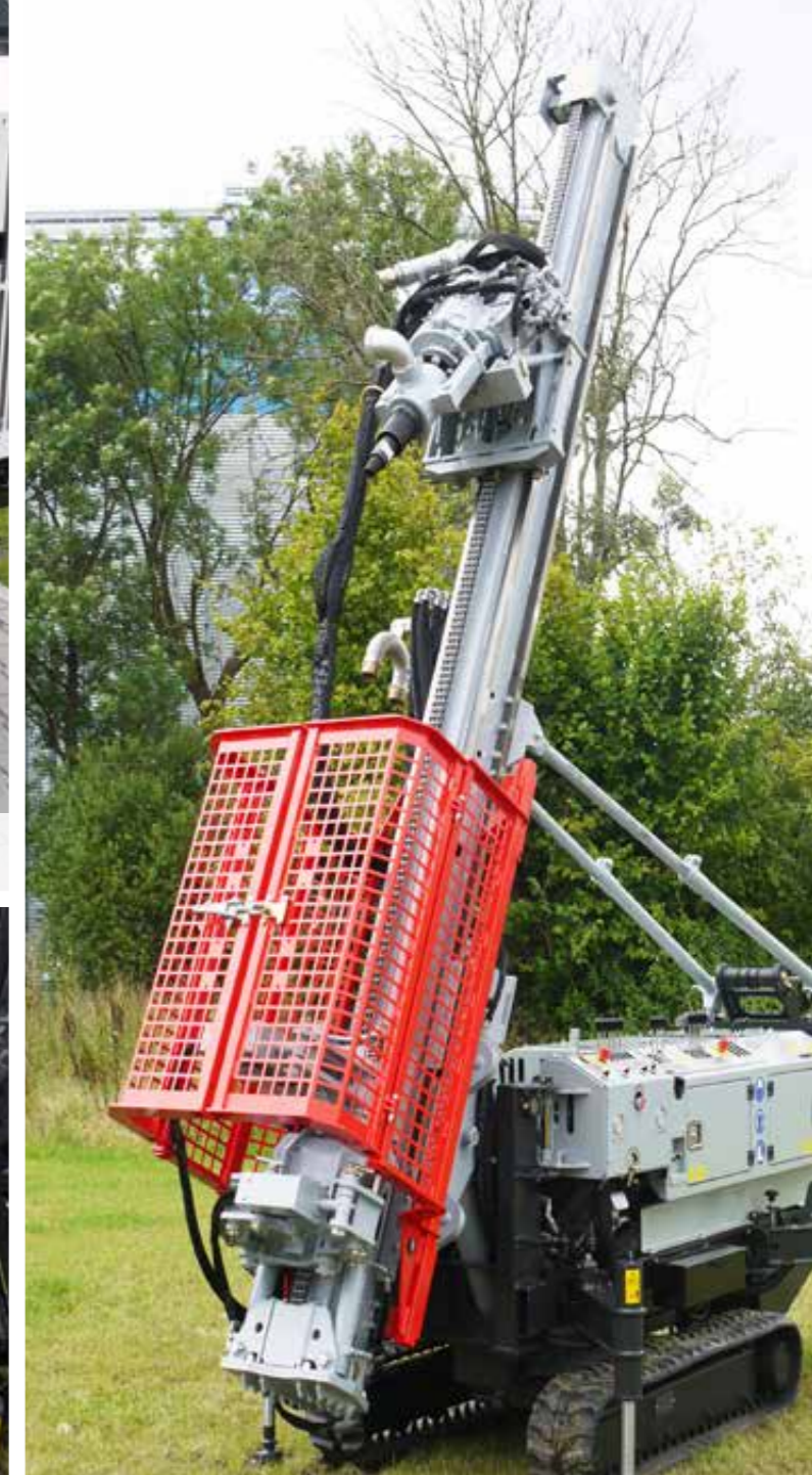
Schrägbohreinrichtung mit Lafettenstützen
