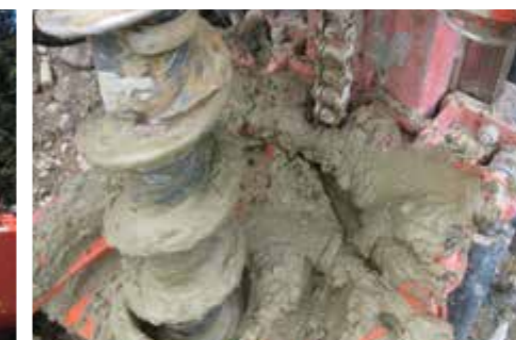
Förderung des Bohrgutes mittels Schnecke
