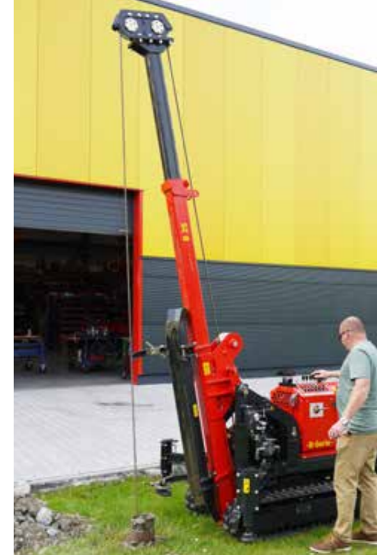
ADLER B 25 Pfahlramme im Einsatz
