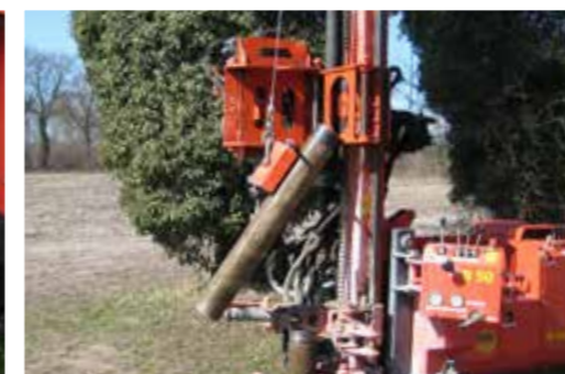
Über die Seilwinde mit Magnet wird das Bohrzubehör dem Bohprozess zugeführt
