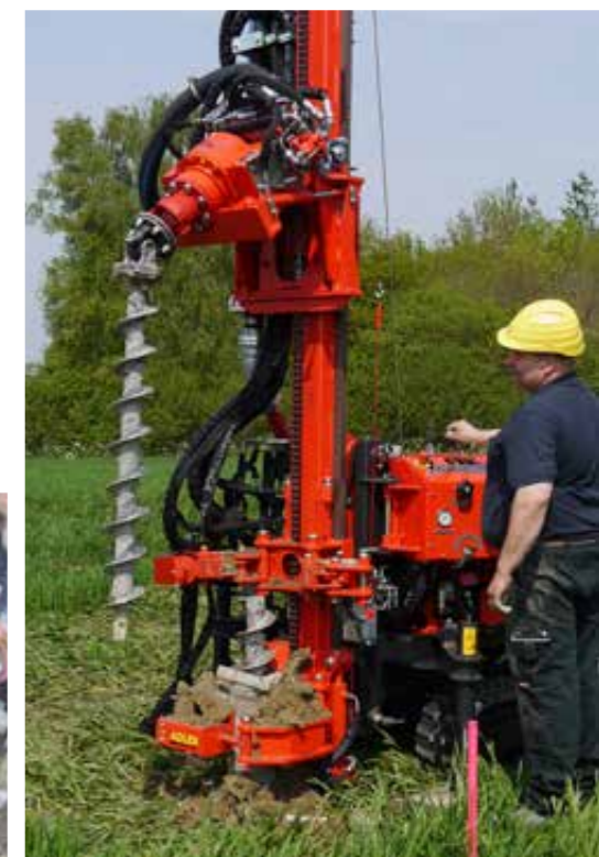
Zum Ausbau der Schnecke wird der Bohrkopf ausgeschwenkt
