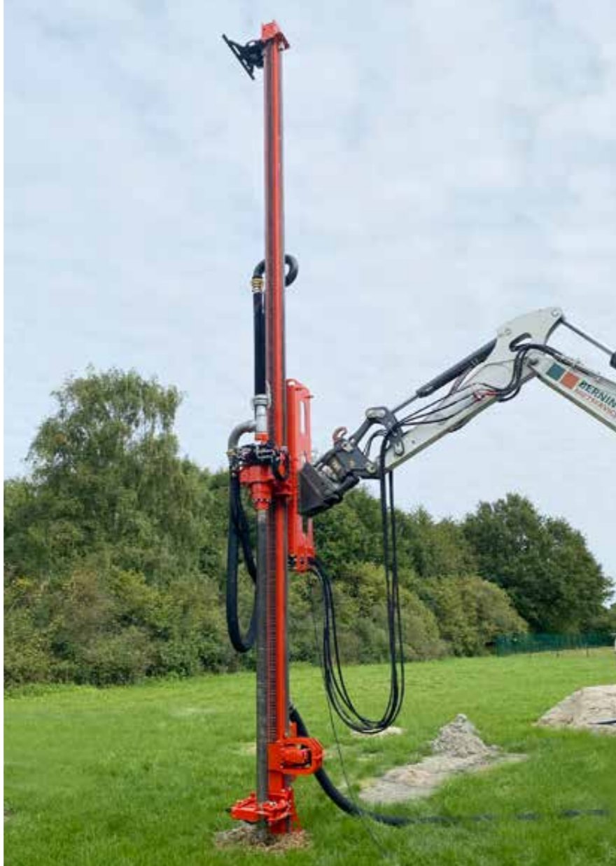
Spülbohren mit einem Wasserkreislauf
