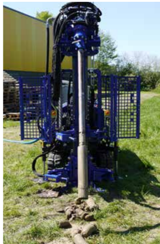
Kernbohrungen mit einem Einfachkernrohr oder mit Doppelkernrohr
