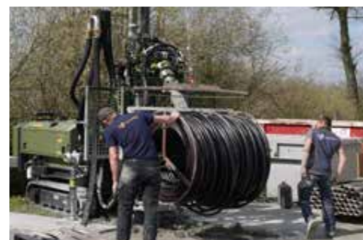
Einbauen einer Erdwärmesonde
