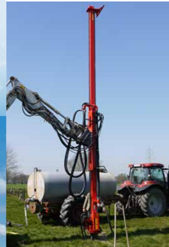
Anbaubohrlafette mit 6,5 m Verfahrweg am 8 t-Bagger
