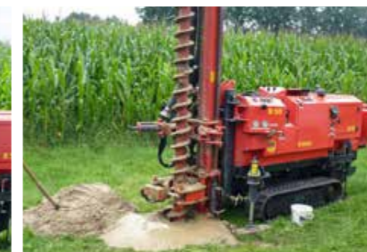
Arbeiten mit der Hohlbohrschnecke
