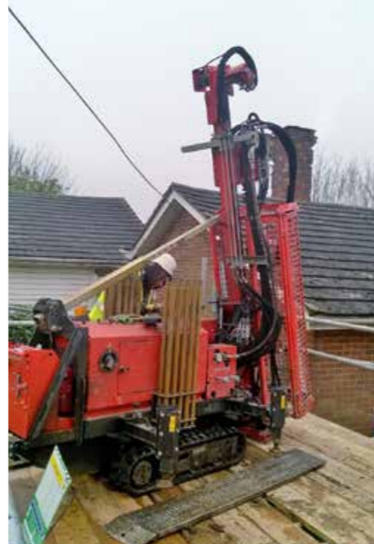
Sondierbohrung zum Orten von Hohlräumen
