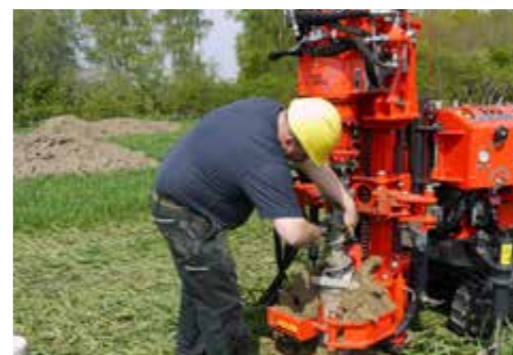
Trockenbohrung mit Außenverrohrung
