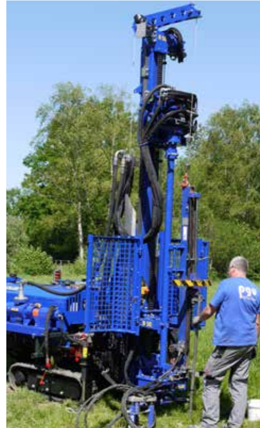
Rammsondieren mit dem ADLER-Bohrgerät B 50
