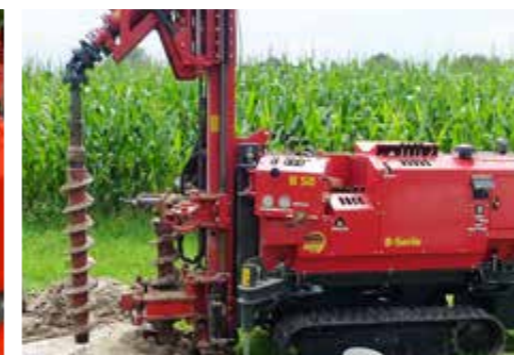
Bohren mit Hohlbohrschnecke und Kreuzgelenk
